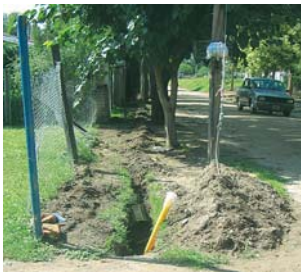
Sector de la intersección de las calles San Juan y San Luis donde se observan los pozos y la colocación de los caños.
